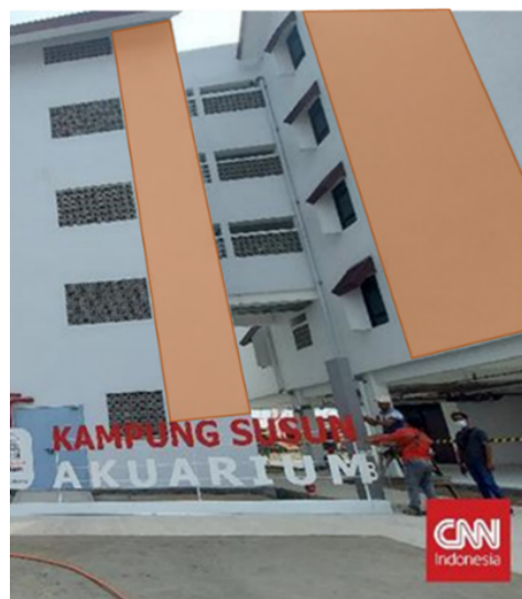
Gambar 12. Selubung Bangunan Rumah Susun Kampung Akuarium (Sumber: CCN Indonesia 2021, Disunting Oleh Penulis Pada 2022)
