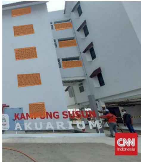
Gambar 13. Selubung Bangunan Rumah Susun Kampung Akuarium (Sumber: CCN Indonesia 2021, Disunting Oleh Penulis Pada 2022)
