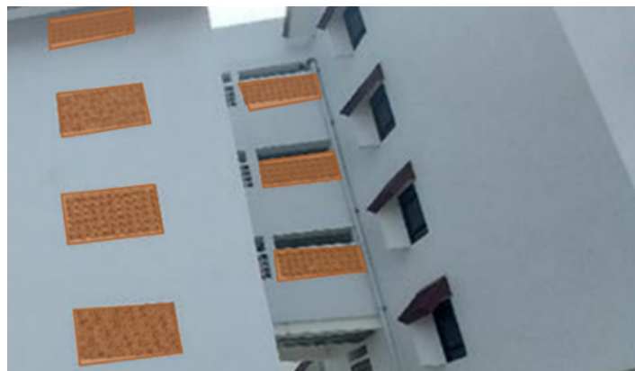
Gambar 24. Selubung Bangunan Rumah Susun Kampung Akuarium (Sumber: CCN Indonesia 2021, Disunting Oleh Penulis Pada 2022)
