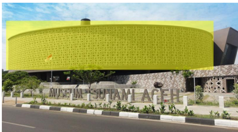
Gambar 9. Fasad Museum Tsunami Aceh (Sumber: Analisis Pribadi, 2021).
