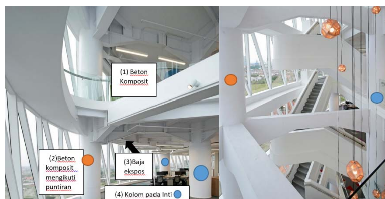
Gambar 10. (1) Balok Beton komposit yang terdiri dari baja yang tertutup beton, (2) beton komposit yang mengikuti puntiran, (3) Balok baja ekspos/bukan komposit pada perbalokan yang ada di pola utama radial, (4) Kolom beton yang tetap lurus membentuk pola radial. Sumber: Sketsa Grafis Penulis, 2024
