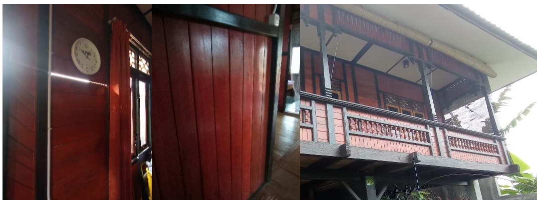
Gambar 5. Gambar A. Celah dinding yang identik dengan dinding bernafas; Gambar B. Dinding leger yang diapit dengan balok datar; Gambar C. Ornamen pada ralling teras depan (Sumber: penulis, 2022)
