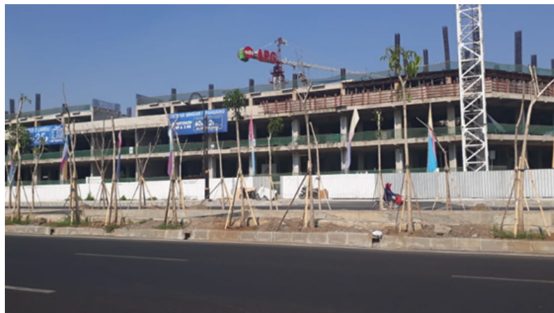
Gambar 5. Pembangunan mall dan apartemen Sumber: Analisis Penulis, 2019
